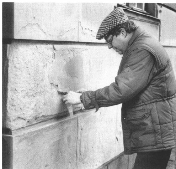
Exempel på sandning och exfoliering på ytan av kalkbunden gotländsk sandsten. Provtagning på Stockholms Slott. Foto Harald Sundlin, RAÄ.
