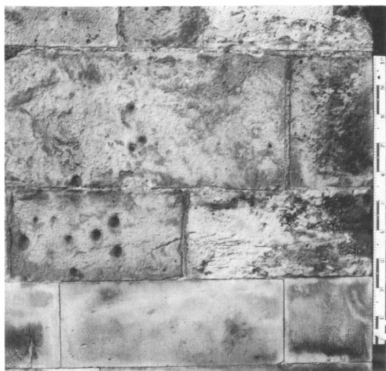
Gropvittring, mörka missfärgningar och viss lavbeväxt på Höörsandsten, Lunds domkyrka. Foto Bengt A. Lundberg, RAÄ.
