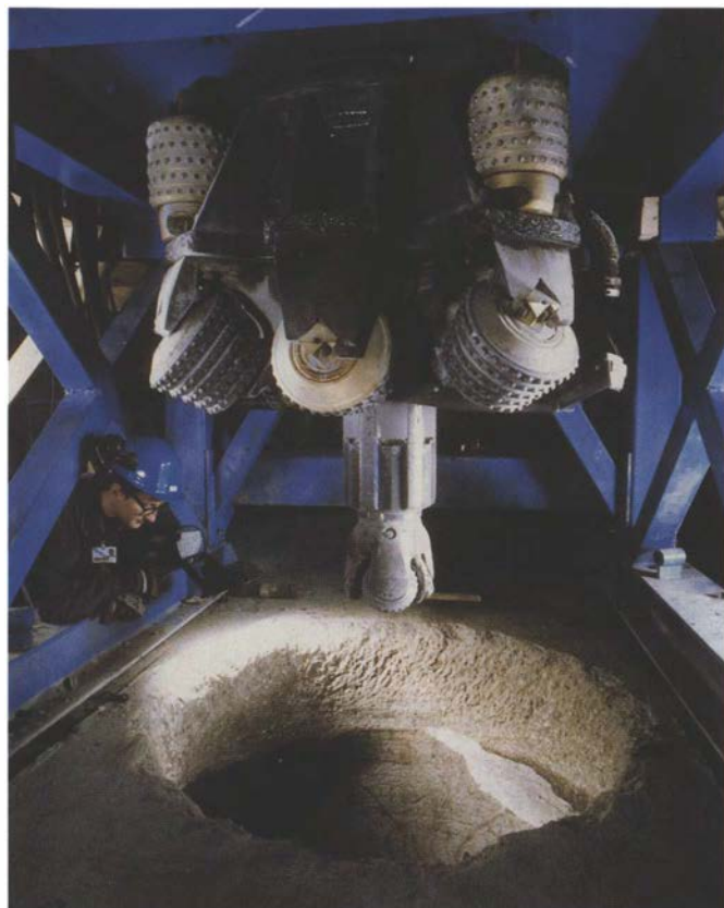
Bild 5. Provbörning av deponeringshål. På bilden syns borrkrona samt överdelen av ett borrhål med diametern 1,5 meter.
