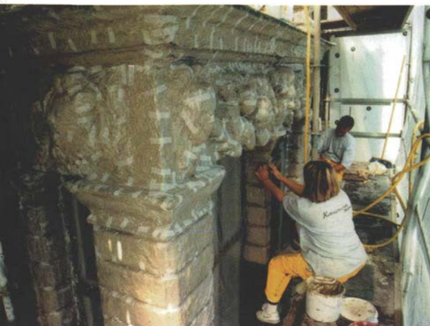
Bild 4. Rengöring. Bentonitmslag innehållande svaga kemikalier påföres stenyrtorna. På så sätt hålles ytan fuktig under önskad tidsrymd och stenyrtan blir senare lättare att efterrengöra med borstar och skalpell. Ratoshuset, Drottninggatan/Strömgatan, Stockholm. Foto förf.
