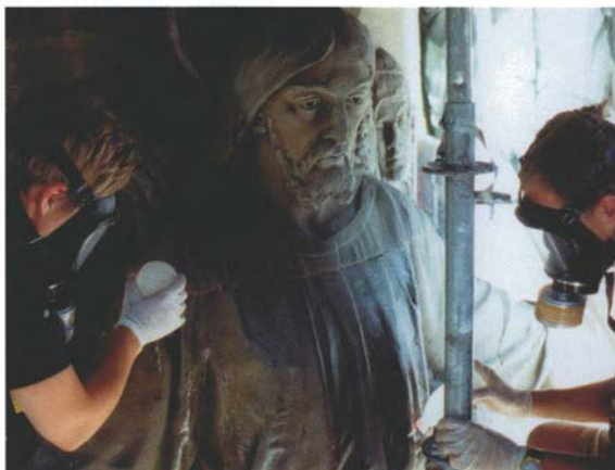
Bild 2. Konsolidering. Skulpturen totalkonsolideras genom s.k. permanent genomflöde, dvs. impregneringsvätskan tillförs utan avbrott till dess att stenen är mättad. Den här skulpturen absorberade ca 45 liter på 7 timmar, 3 personer arbetade. S:t Peters Metodistkyrka, Stockholm. Foto förf.
